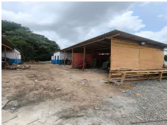
Foto 01: Canteiro de obra
