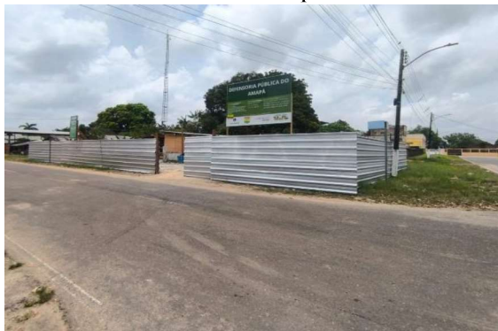
Foto 13: Fechamento com tapume metálico
