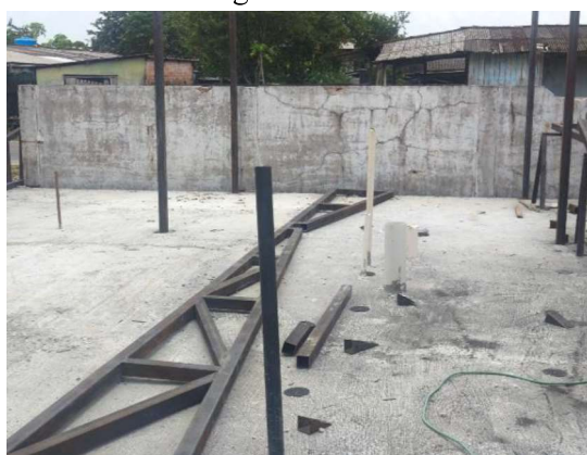
Foto 04: Concretagem e drenos
