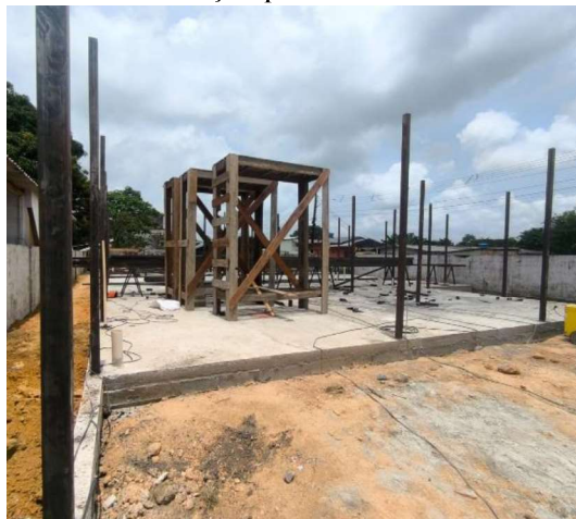
Foto 08: Instalação pilares metálicos
