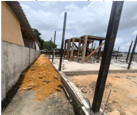
Foto 07: Espalhamento e compactação calçada
