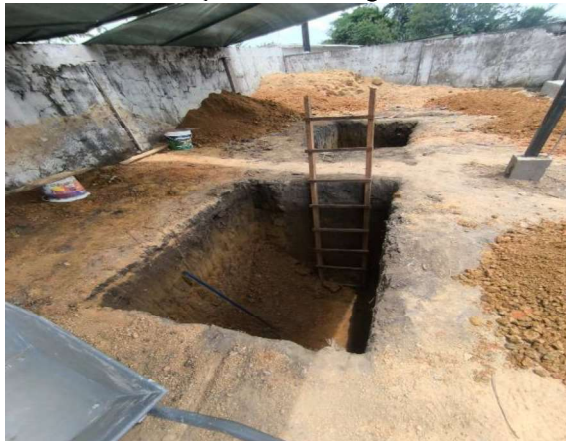
Foto 05: Escavação rede de esgoto
